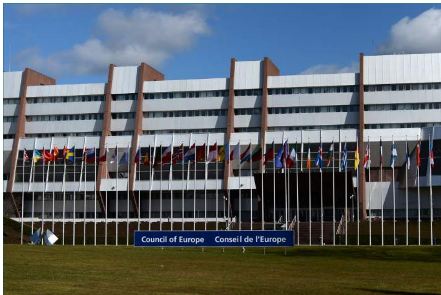
Адміністративна будівля Ради Європи «Палац Європи» (м. Страсбург, Франція)
